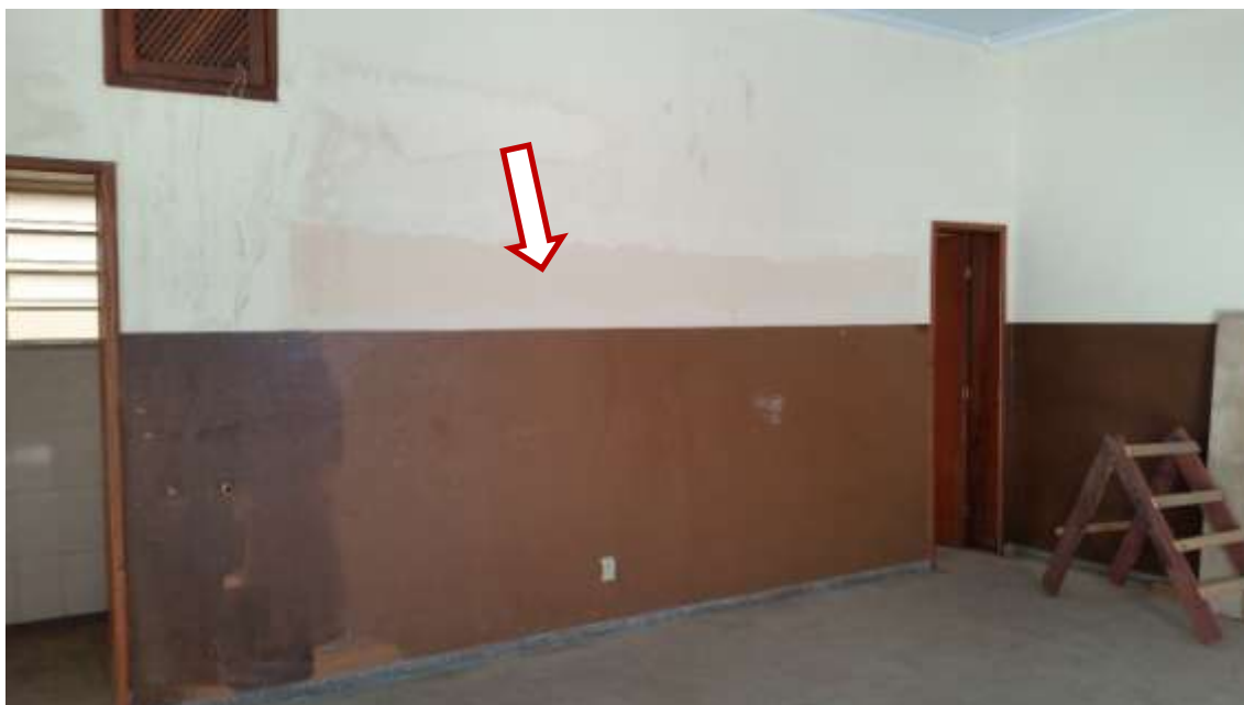
Foto 12 – No segundo andar, vemos parte de parede que será removida para aumento da cozinha.
