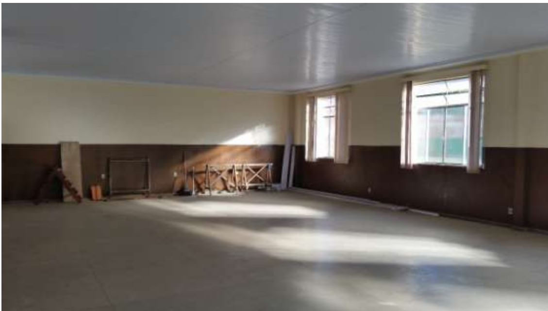
Foto 14 – Ainda no segundo andar, vemos parte do salão que será dividido entre plenário e sala de reuniões, para tanto serão instaladas divisórias.
