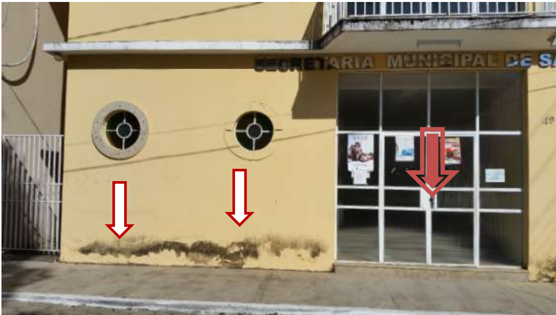
Foto 02 – Foto da fachada principal, focada no pavimento térreo. Aqui serão abertas duas portas e trocada a porta de acesso ao pavimento térreo.
