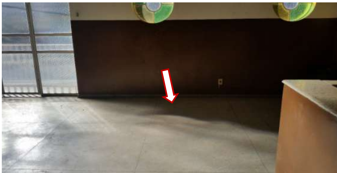
Foto 15 – Detalhe do piso do segundo andar o qual será cortado para a passagem da estrutura que sustentará a plataforma de acesso.
