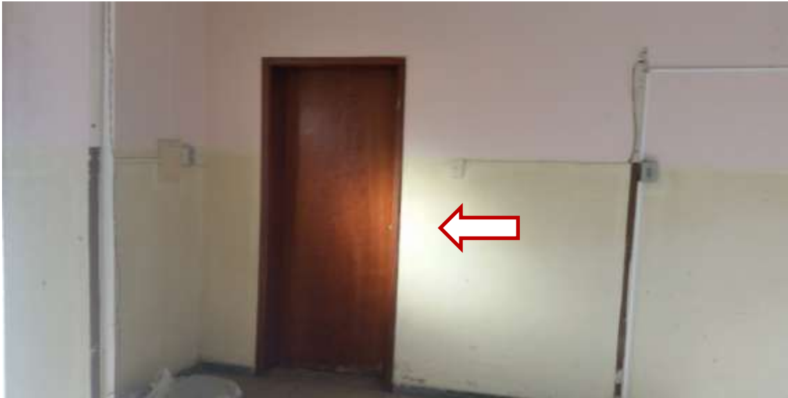
Foto 08 – Foto interna mostrando a porta mencionada na foto 04, a qual será removida, bem como parte da parede a esquerda. A nova porta a ser instalada será de correr.
