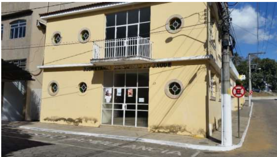
Foto 01 – Prédio em questão. Foto mostra fachada principal.
