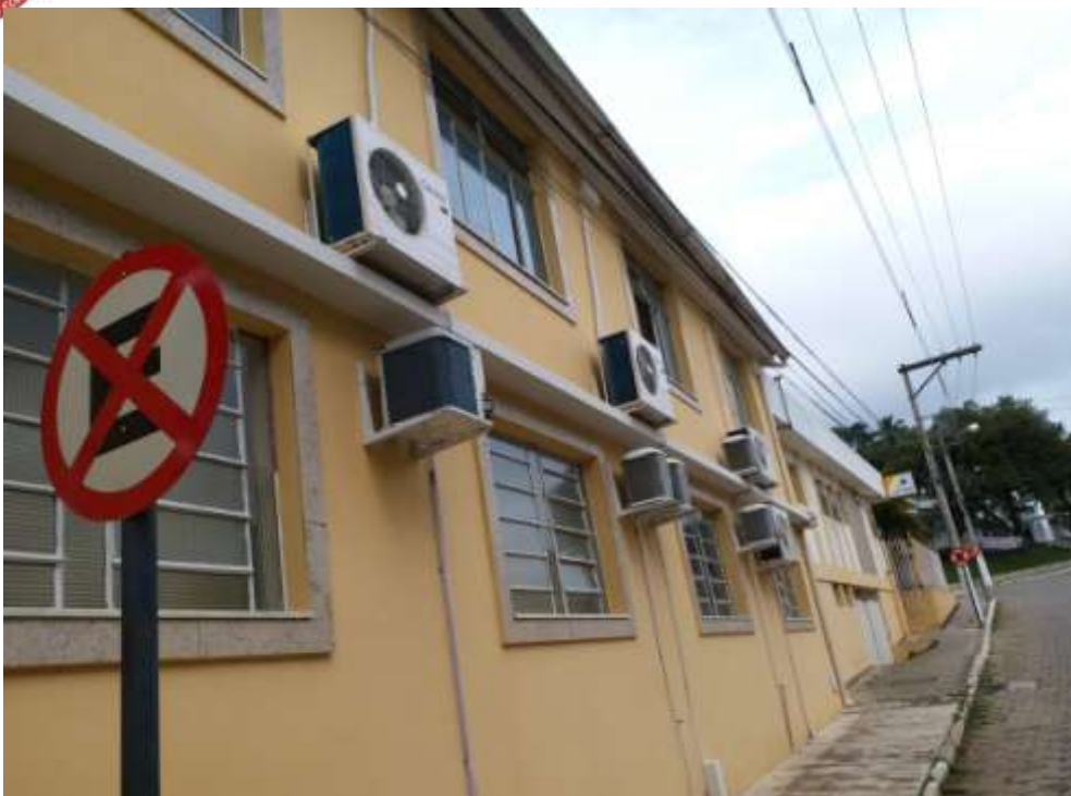
Foto 02 - Foto da lateral do prédio. Aqui serão trocadas todas as janelas.
