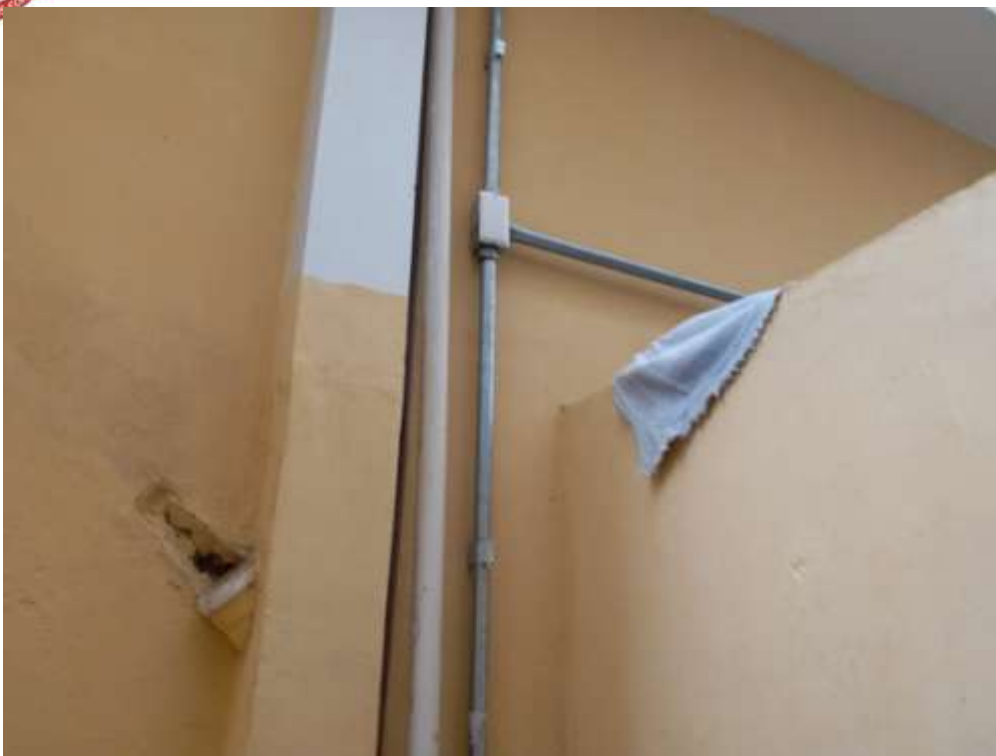
Foto 14 – Foto da parte inferior de onde será executada a laje. Parede no lado direito da foto será demolida.
