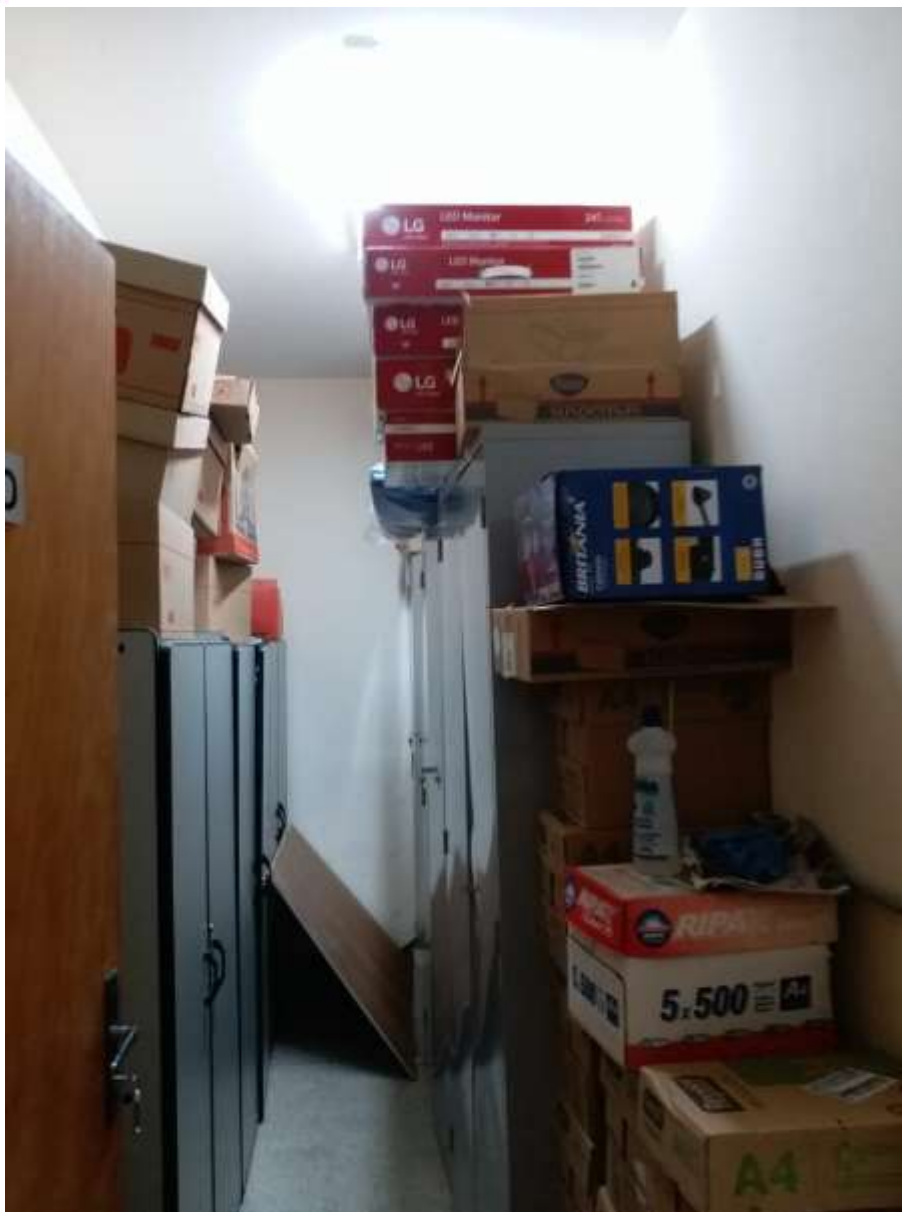
Foto 10 – Foto do cômodo Arquivo. Toda parede do lado esquerdo da foto será demolida para ampliação do espaço.
