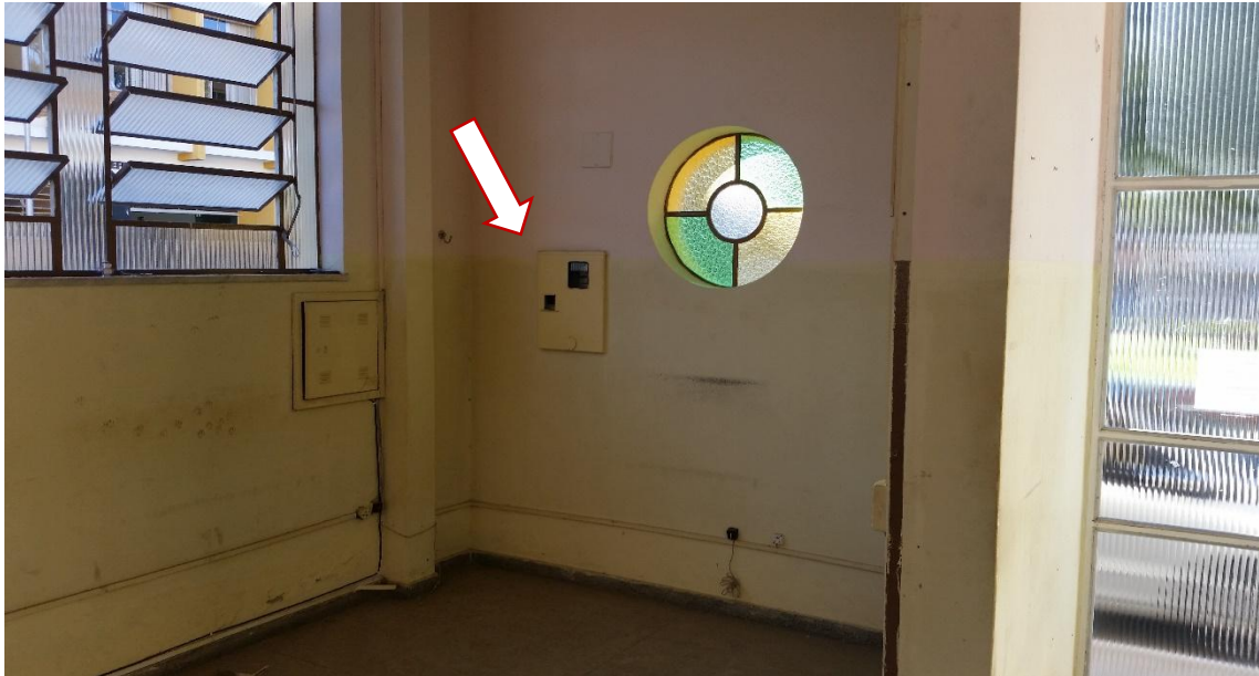
Foto 06 – Foto interna mostrando onde será instalado o novo padrão de entrada de energia.
