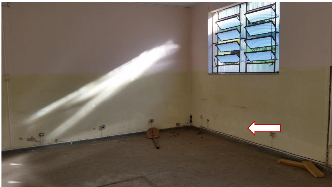
Foto 07 – Foto interna mostrando a situação atual do prédio; podemos ver um início de deterioração da argamassa por conta de umidade ascendente e a necessidade de pintura das paredes. Nas paredes serão instalados os eletrodutos galvanizados externos e para dividir em salas serão instaladas divisórias.
