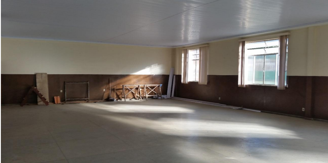
Foto 14 – Ainda no segundo andar, vemos parte do salão que será dividido entre plenário e sala de reuniões, para tanto serão instaladas divisórias.
