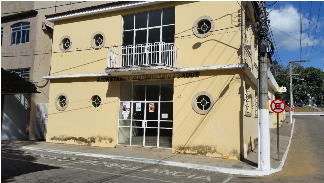
Foto 01 – Prédio em questão. Foto mostra fachada principal.
