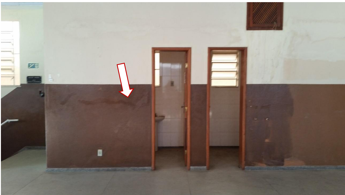
Foto 13 – No segundo andar, parte de parede que será removida para aumento da porta do banheiro que será adaptado para pessoas com necessidades especiais.
