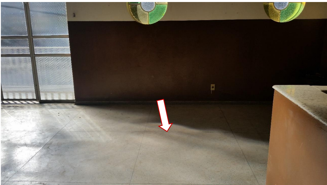
Foto 15 – Detalhe do piso do segundo andar o qual será cortado para a passagem da estrutura que sustentará a plataforma de acessibilidade.
