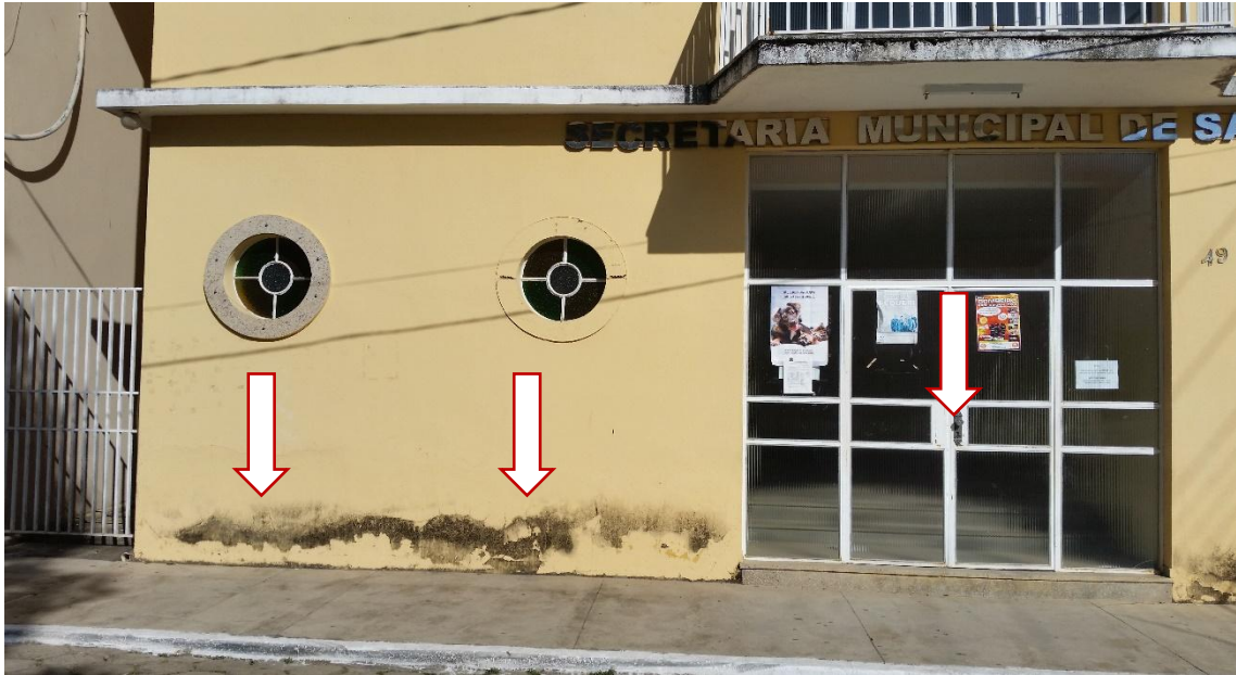
Foto 02 – Foto da fachada principal, focada no pavimento térreo. Aqui serão abertas duas portas e trocada à porta de acesso ao pavimento térreo.
